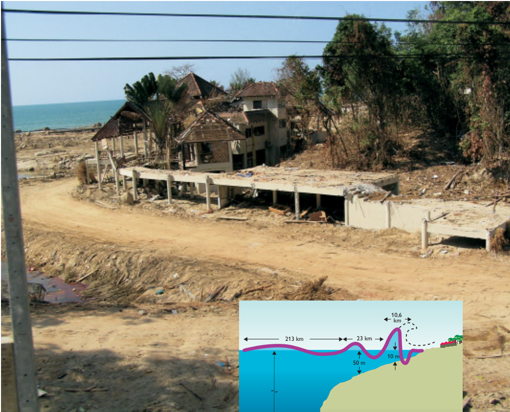
Et hus på stranden i Thailand efter Tsunamien.
